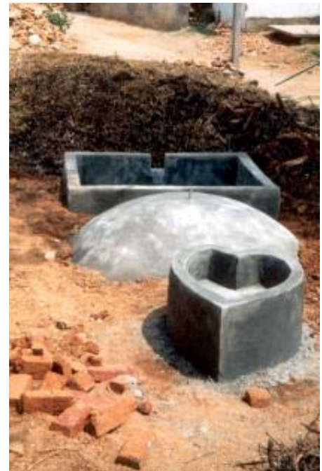
Een biogasinstallatie in aanbouw. Op de voorgrond de invoertank, in het midden de luchtafgesloten tank met gasafvoeraansluiting en op de achtergrond de uitvoertank.
